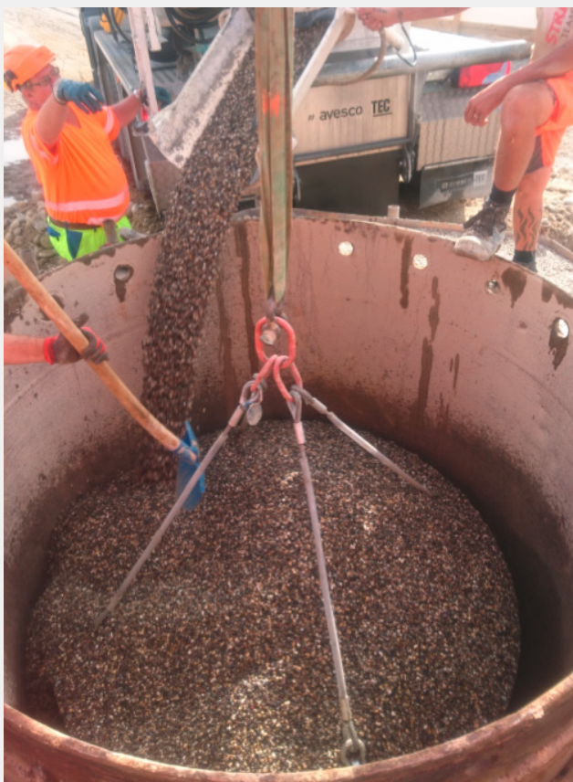
Fig. 11 Einbringen der Filterkiesschüttung. (Jäckli Geologie AG)
