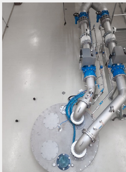
Fig. 8 Brunnen mit zwei Unterwasserpumpen. (BSB + Partner)
