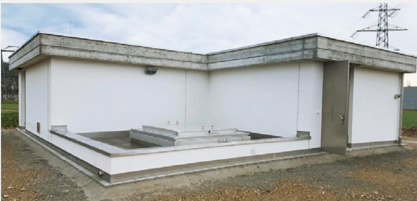
Fig. 14 Pumpenhaus mit einem direkt über dem Brunnen angeordneten Bodentor für den direkten Ausbau der Pumpen.
